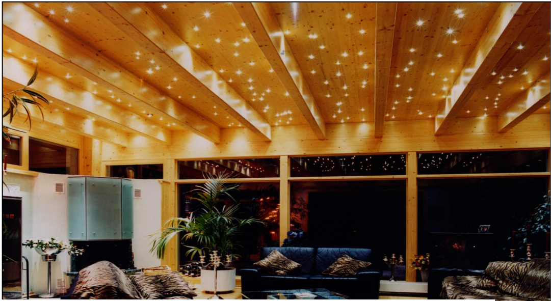
1 Lichtprojektor MHR 100 W versorgt 500 x 1mm Lichtfasern, Länge bis zu 15 m Bei 35 m 2 Raumfläche wurde auf zusätzliche konventionelle Beleuchtung verzichtet.
